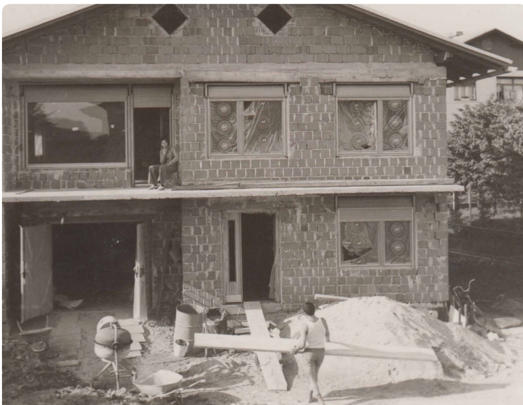
Gradnja hiše v Ormožu, junij 1977. Foto, hrani: družina Brumen. 140
